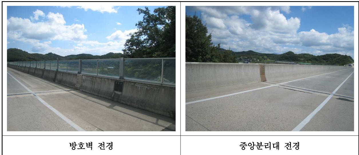
【사진 30.3.48】 방호벽 및 중앙분리대 전경
