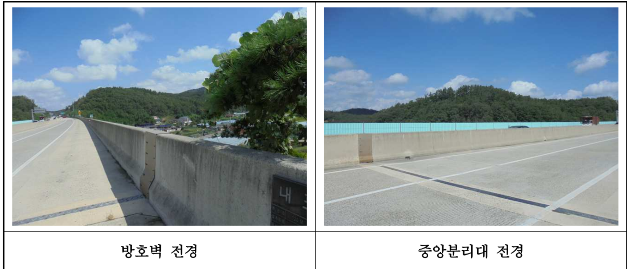
【사진 30.3.23】 방호벽 및 중앙분리대 전경
