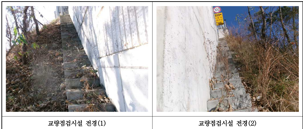
【사진 30.3.50】 교량 점검시설 전경
