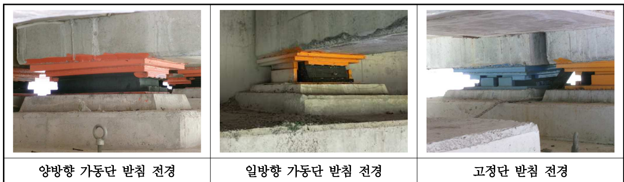
【사진 30.3.37】 교량받침 전경
