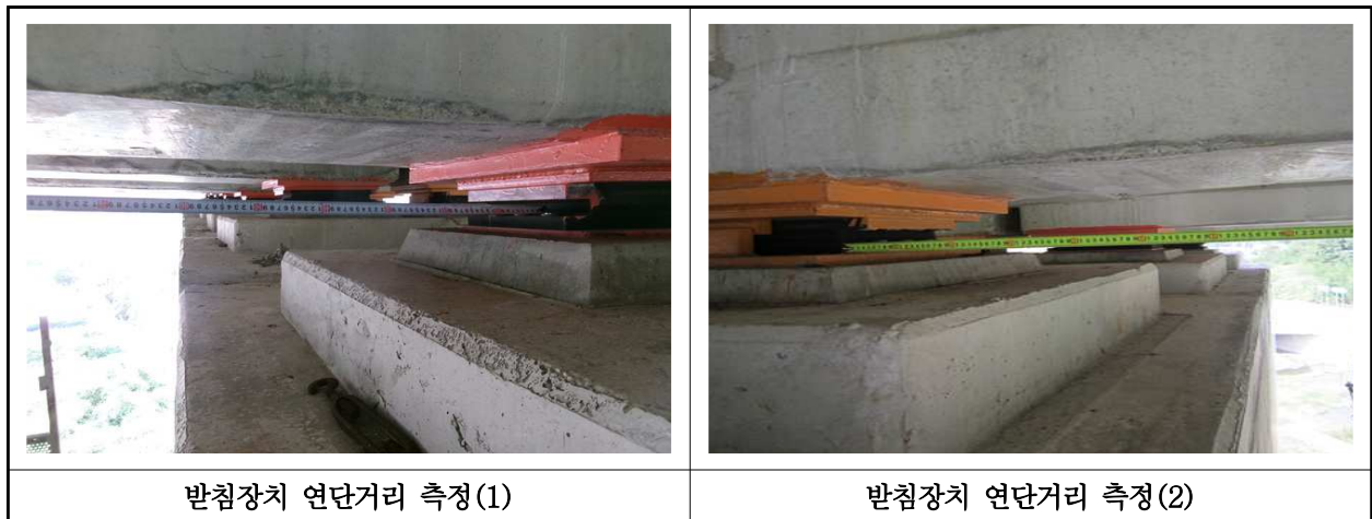
【사진 30.3.39】 교량받침장치 연단거리측정
