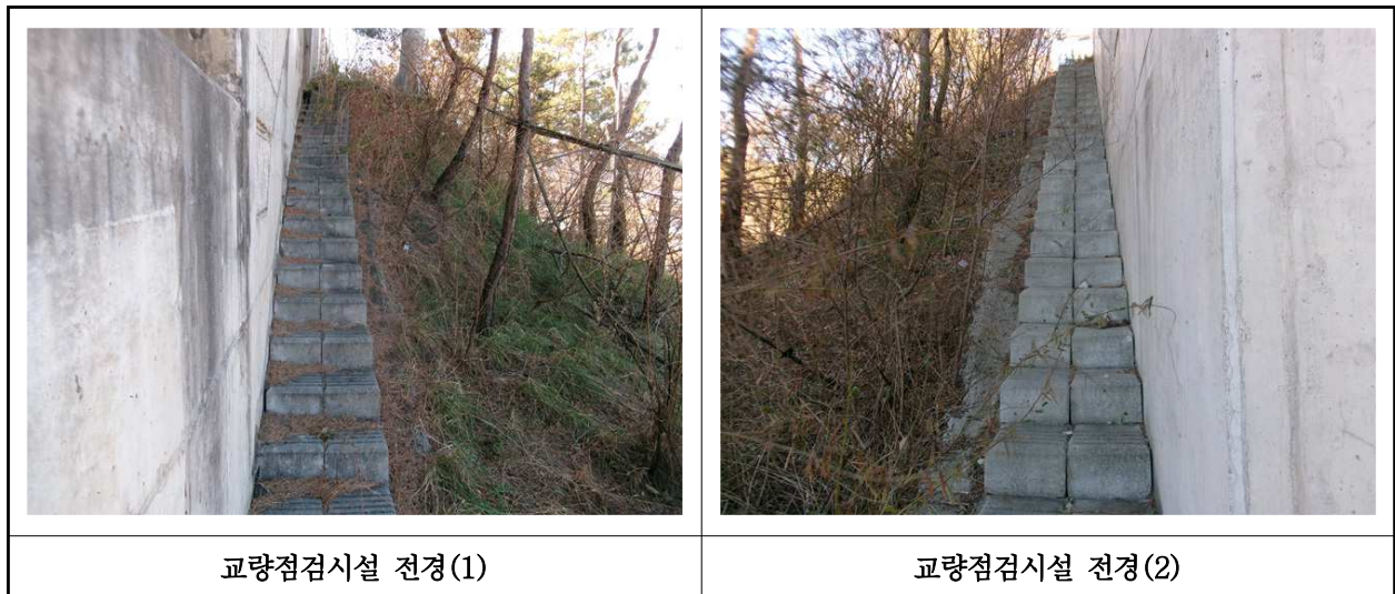
【사진 30.3.25】 교량 점검시설 전경
