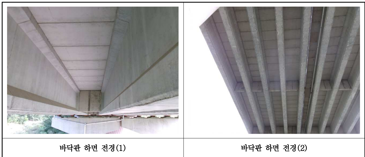
【사진 30.3.27】 바닥판하면 전경
