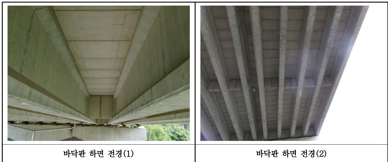
【사진 30.3.2】 바닥판하면 전경
