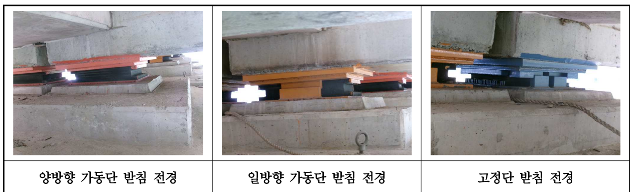
【사진 30.3.12】 교량받침 전경
