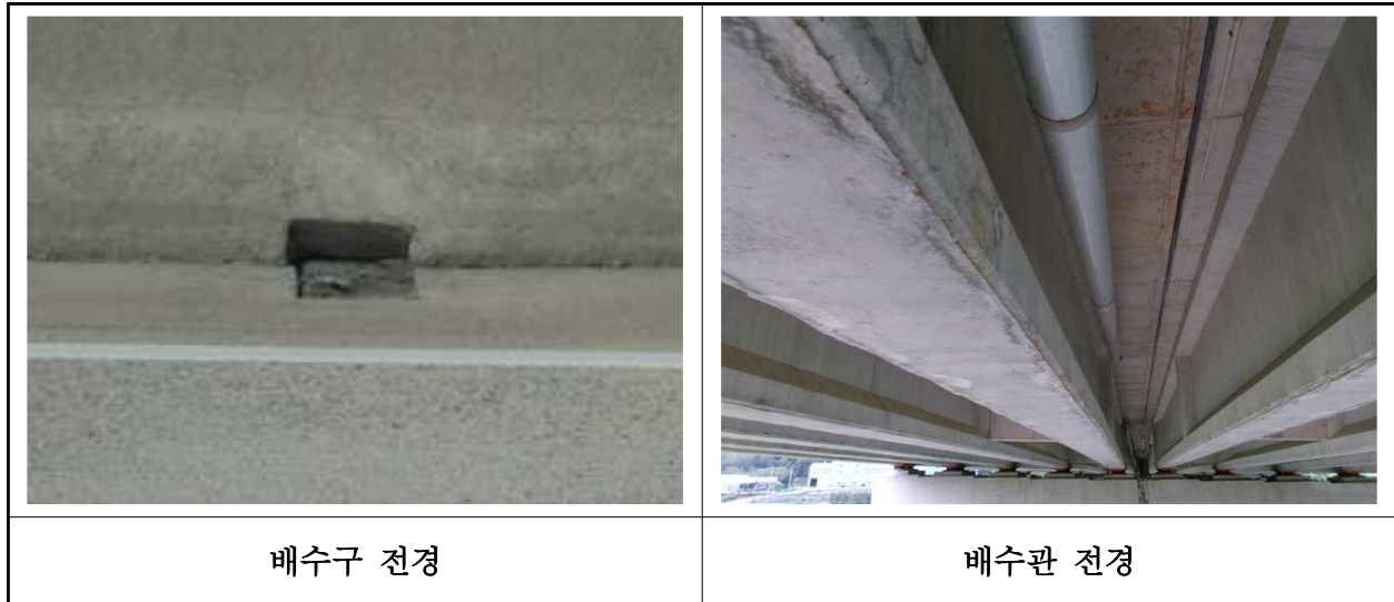
【사진 30.3.21】 배수시설 전경
