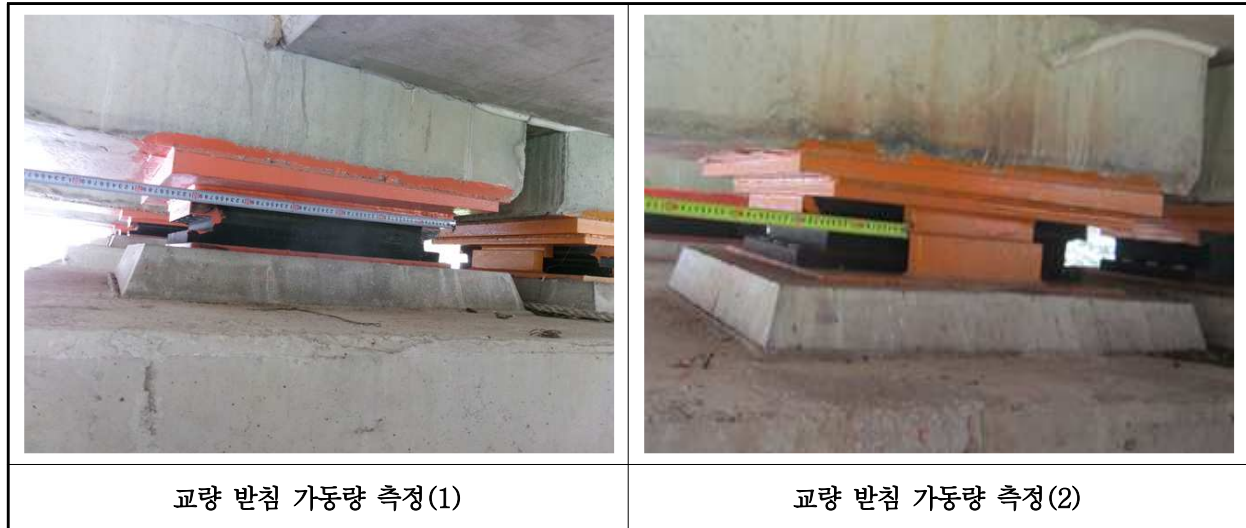
【사진 30.3.40】 교량받침 이동량 상태
