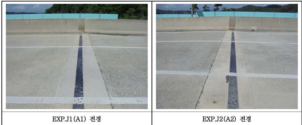
【사진 30.3.41】 신축이음장치 전경
