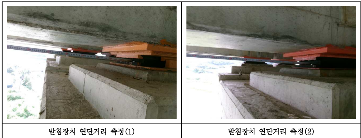
【사진 30.3.14】 교량받침장치 연단거리측정
