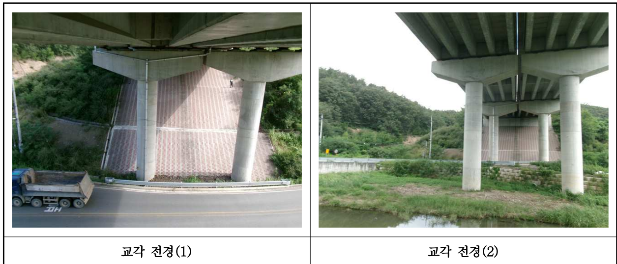
【사진 30.3.35】 교각 전경
