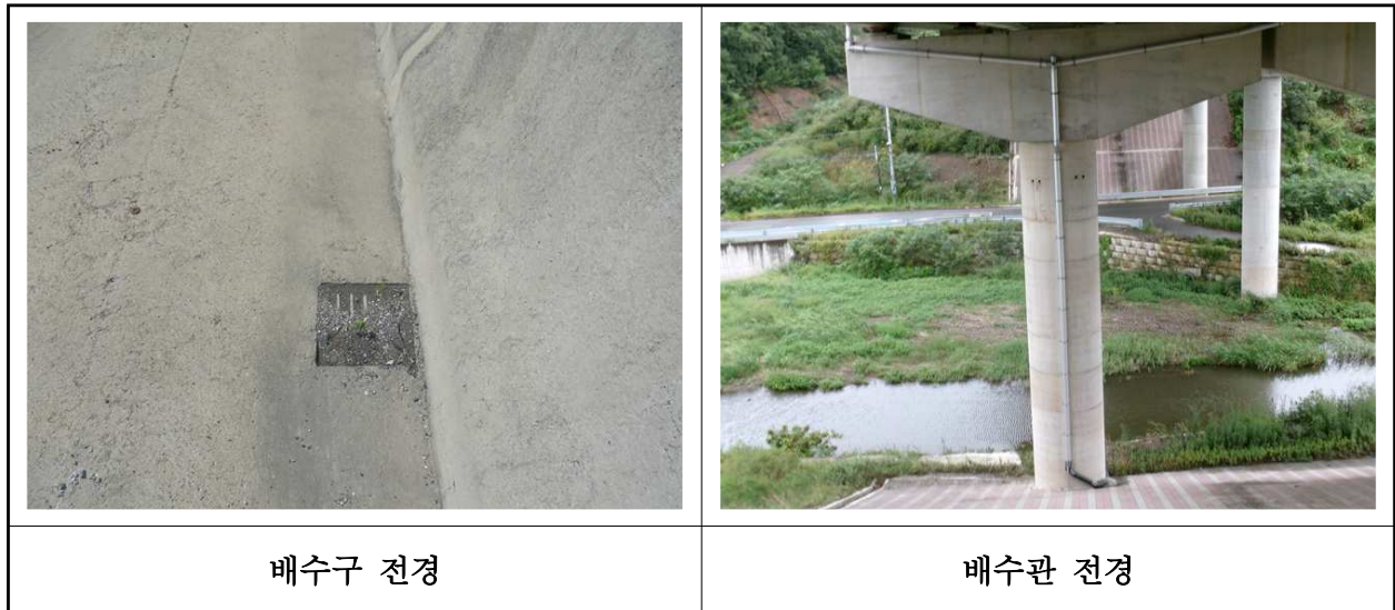
【사진 30.3.46】 배수시설 전경
